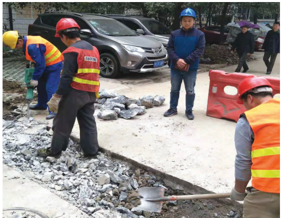
纪检委员巡查项目建设
