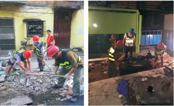
上图维修人员在牧羊湖社区施工现场清理表井箱
