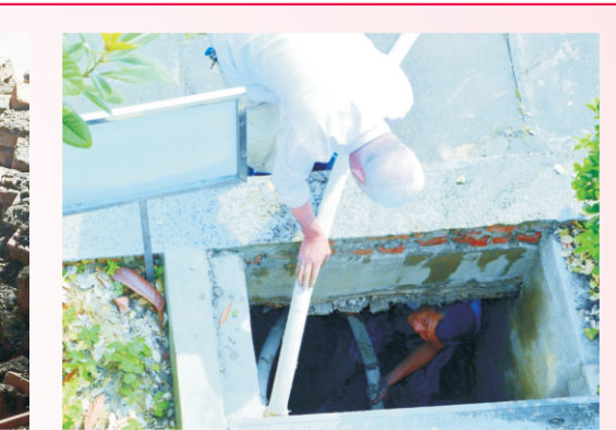
9月8日，为了保证高峰供水水质，凉亭山水厂组织人员对一期反应池进行冲洗时，因反应池放空管道堵塞，造成冲洗工作无法进行。图为水质管理人员罗超配合副厂长胡运强在无法直起腰的狭窄泥污闸门井里用高压水枪对放空管道进行疏通，保证了冲洗工作的顺利进行。（王 芳）
