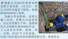
▲根据2023年度供水管网更新计划安排，2月22日，营销公司同施工单位下陆，沿路开挖DN600阀门井。
